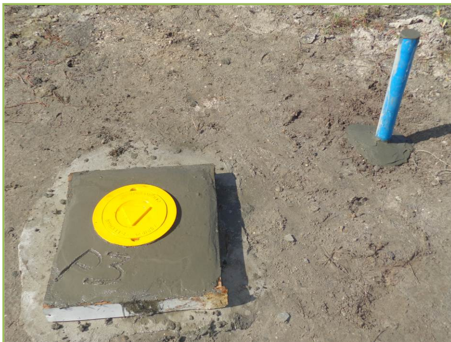
Figura 3.1.8-6: Acabamento pronto com câmara de calçada.
