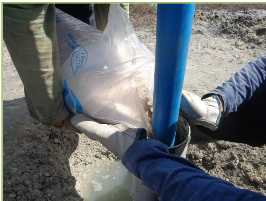
Figura 3.1.8-5: Colocação dos pré-filtro de 2 mm.
