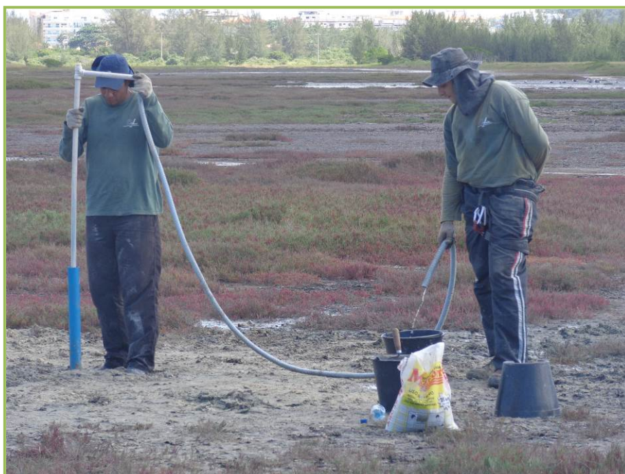
Figura 3.1.8-7: Desenvolvimento do poço.
