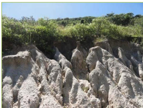
Sulcos ravinares formados pelo escoamento pluvial difuso em corte de talude.
