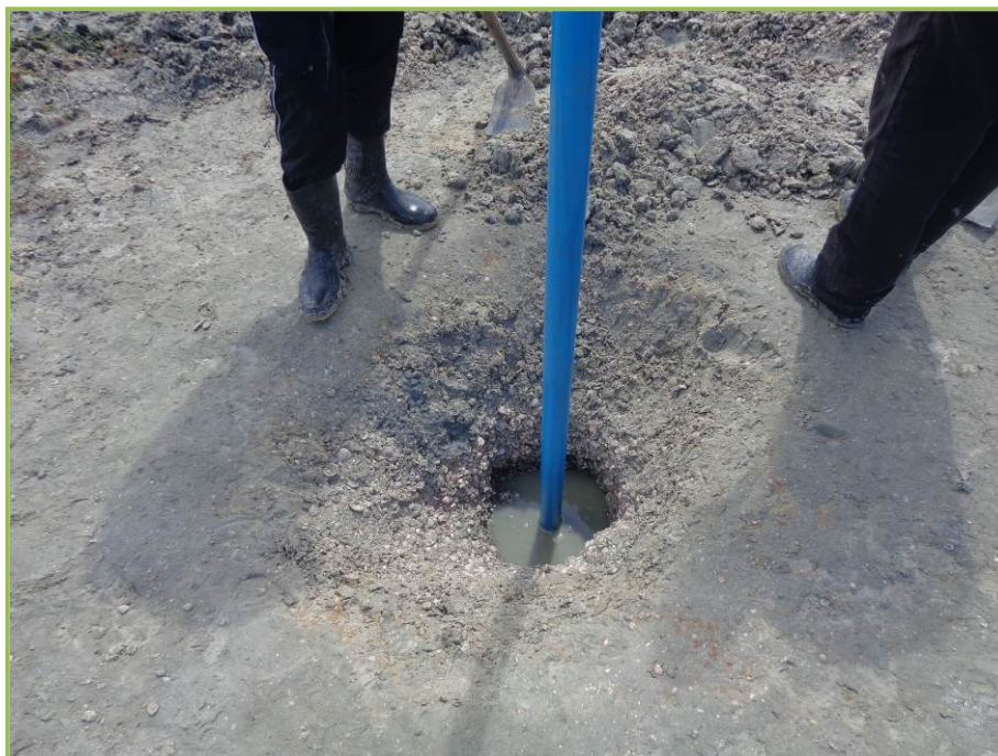
Figura 3.1.8-4: Colocação dos tubos geomecânicos no poço perfurado.
