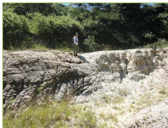
Vista de corte de talude com erosão laminar superficial.
